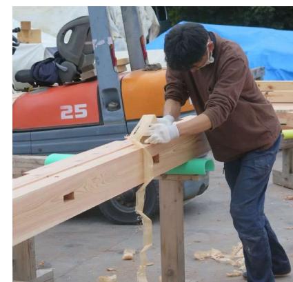
手刻みによる加工、伝統的な継手仕口 🏠 🌳
